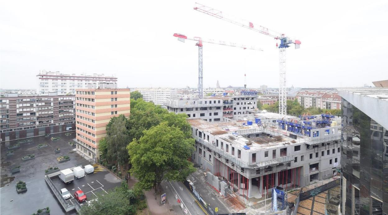
28/12/2022 : Bardage et menuiseries extérieures sur le socle RDC/R+3 et élévations R+9 en cours sous G1
